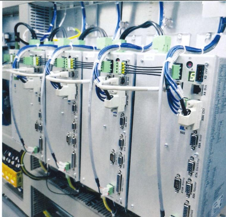
Das Antriebssystem SD2 löst nach und nach den Frequenzumrichter SD25 in den Schleifmaschinen von Danobat-Overbeck ab
